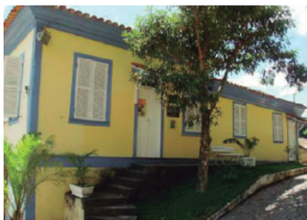
Figura 1 – Casarão, edificado por volta de 1850. Fonte: Martino (2011, p. 7).
